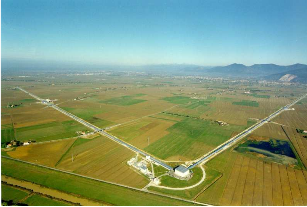
FIG. 6.1 – Vue aérienne du détecteur interférométrique d’ondes gravitationnelles VIRGO, situé à Cascina, près de Pise (Italie). La construction de VIRGO s’est achevée en 2003. Les cavités Fabry-Pérot de chacun des bras de 3 km ont été alignées avec succès et les premières franges d’interférence ont été obtenues en février 2004 [source : CNRS / Istituto Nazionale di Fisica Nucleare].
